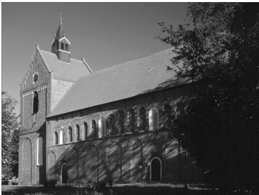
Nordansicht der Kirche
